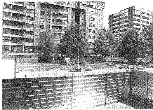
La zona de la excavación se ha vallado esta semana.
