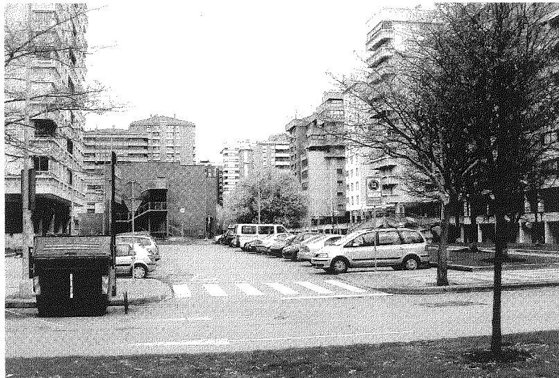
En este fondo de saco al que se accede desde la calle Esquíroz se construirá el parking.
